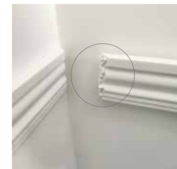
Per una posa corretta applicare proflex tra due profili
