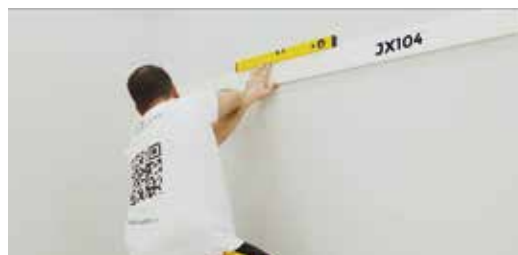
Livello per la posa cornici
